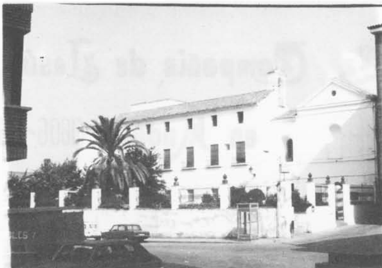
EDIFICIO CONVENTUAL, HOY HOSPITAL MUNICIPAL, QUE FUNDARON LOS JESUITAS EN ANDUJAR.
