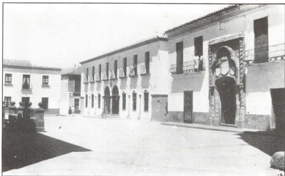
21-(B) Antigua casa solariega de los Albarracín. Fto. 1.960. Al fondo, Casa de Cultura.
