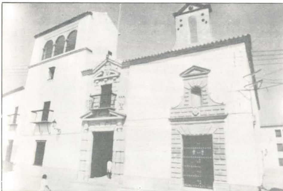
28-(J) Fachada del Palacio del Conde de la Quintería en el 1.918, antigua casa solariega de los Cárdenas y hoy Palacio de Justicia.
