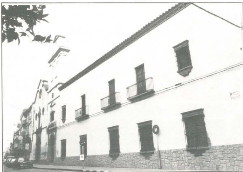
43-(H) Iglesia y Convento de San Juan de Dios, hoy residencia de ancianos. Foto 1,985.
