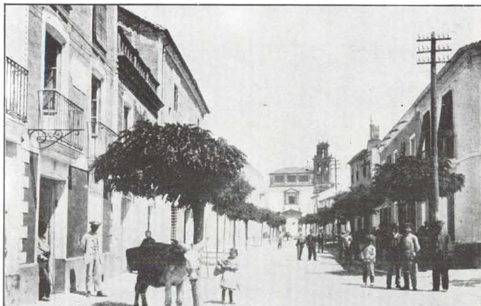
42-(C) Calle 22 de Julio en el 1.910, al fondo Convento de las Trinitarias.
