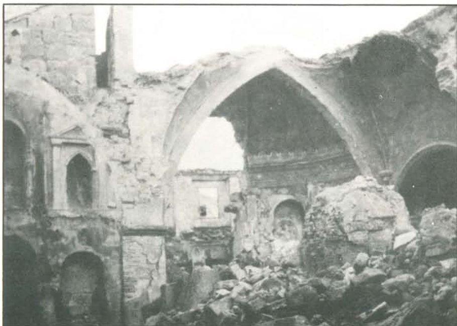
163-(B) Interior del Santuario al terminar el asedio, Mayo 1.937. Años después, el Santuario se levantaría sobre sus cenizas y escombros.
