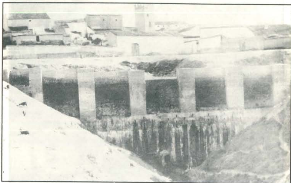
(B) Muro de contención en la Plazuela del Pilar. Años 40
