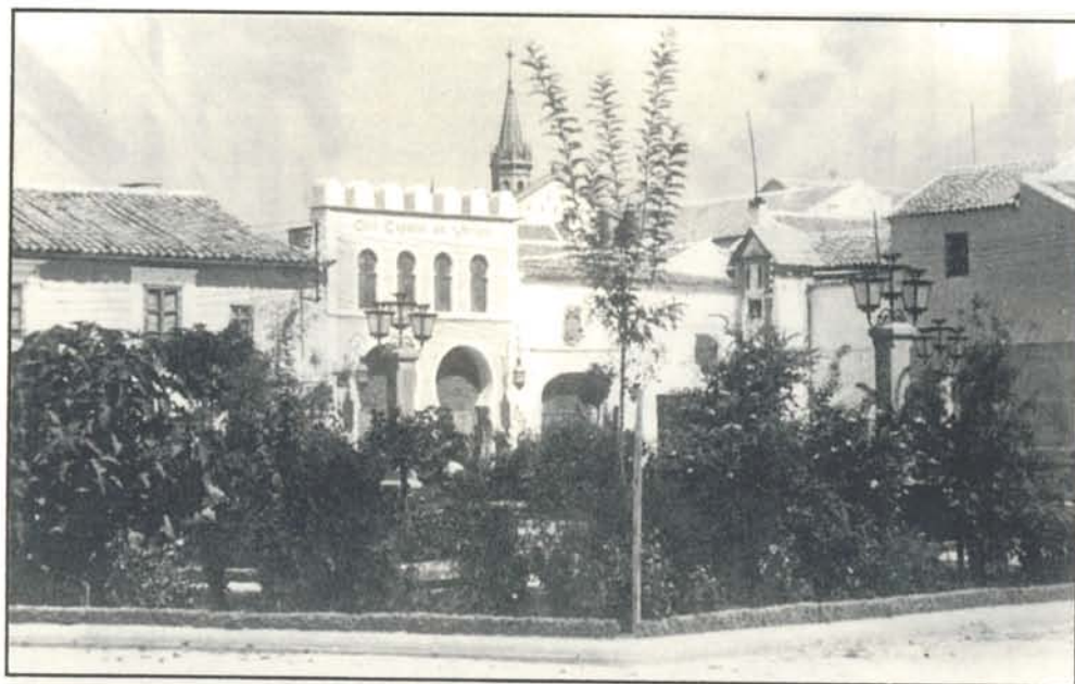
(A-3) Cine Español de Verano. Foto 1.950. En este paraje se levantan nuevas edificaciones.
