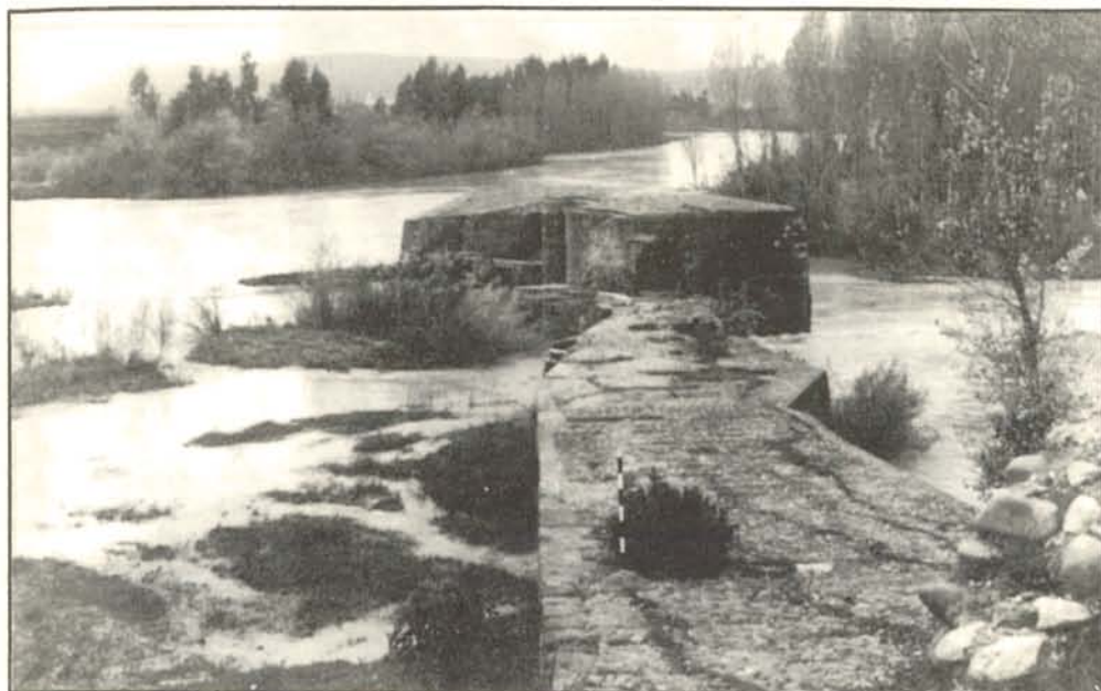
(C) Molino Medieval, junto al Guadalquivir, por la carretera de los Villares de Andújar. Foto Delgado, 1985.
