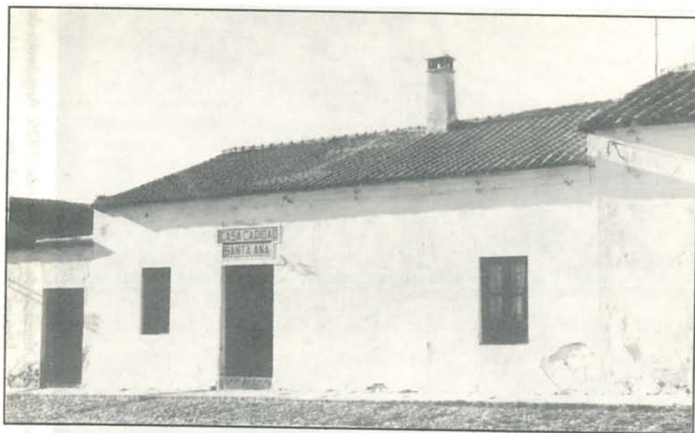
(B). Casa Caridad construida en los años 50, de la Santería de la Ermita Santa Ana en la calle Santa Ana.
